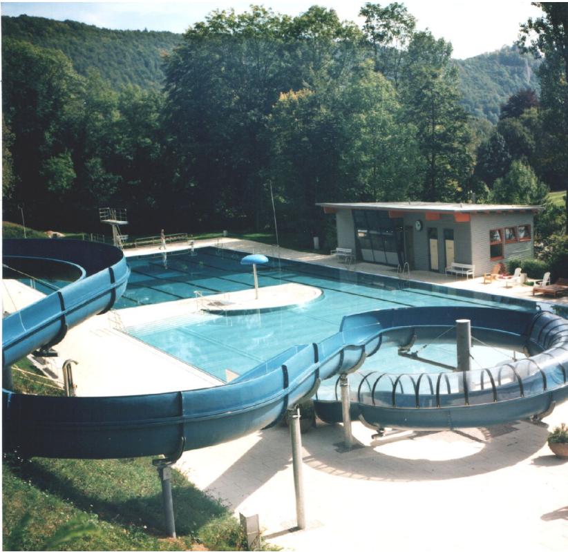
Abb. 1: Kombibecken mit Großwasserrutsche und Technikgebäude
